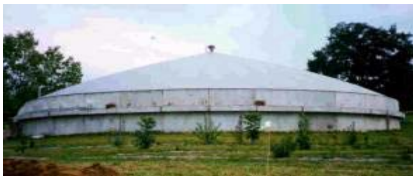
Digesteur par couverture de fosse à lisiers.
